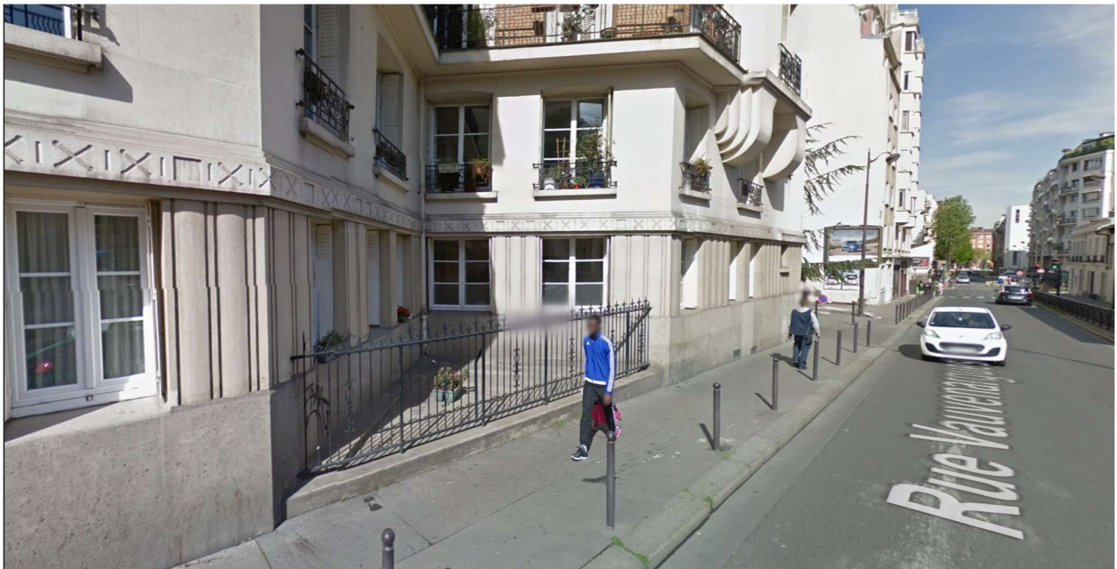
Rue Vauvenargues, Paris
